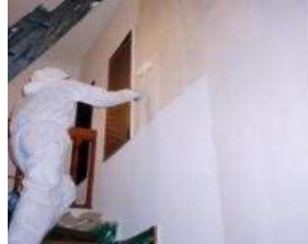
施工中(東京都住宅)
