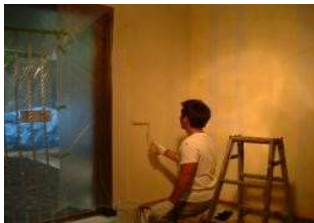
施工中(神奈川県宿泊施設)
