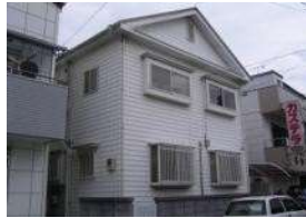
施工後(長崎県住宅)
