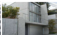
住宅外壁疎水材塗布
