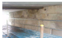
橋梁劣化防止
