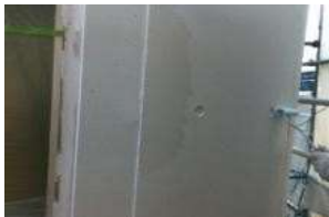
施工中(東京都マンション)
