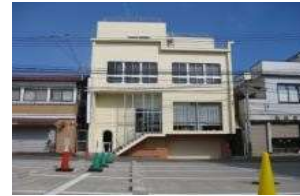
施工後(青森県住宅)
