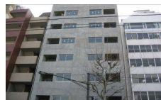
マンション外壁疎水材塗布
