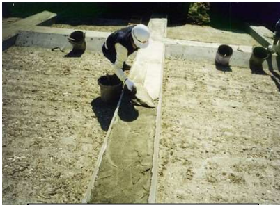
〈欠落部補修状況〉
