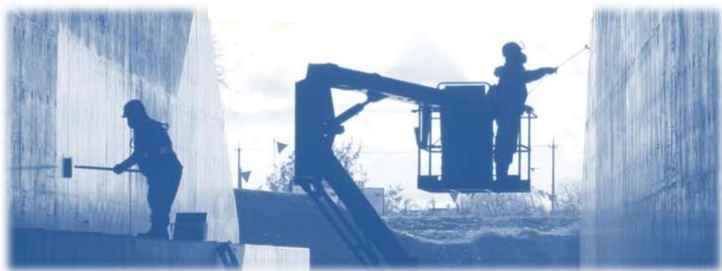
**バリアシラン**はアルコキシシロキサンを主成分とした表面含浸材です。コンクリートやモルタル等の多孔質材料へ塗布、浸透させることにより、強固な吸水防止層を早期に形成し、塩化物イオンや水分等の劣化因子の侵入を抑制します。
