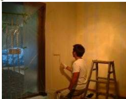
施工中(神奈川県宿泊施設)
