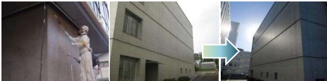
施工中(東京都研究施設)
