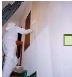
施工中(東京都住宅)
