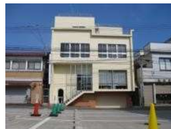
施工後(青森県住宅)
