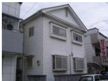
施工後(長崎県住宅)
