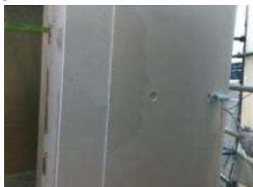
施工中(東京都マンション)
